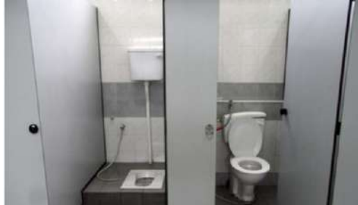
Gambar 3. Pembangunan bilik toilet di gedung Fakultas Universitas Malikussaleh dengan 2 jenis type toilet yang mengadopsi kenyamanan gender
