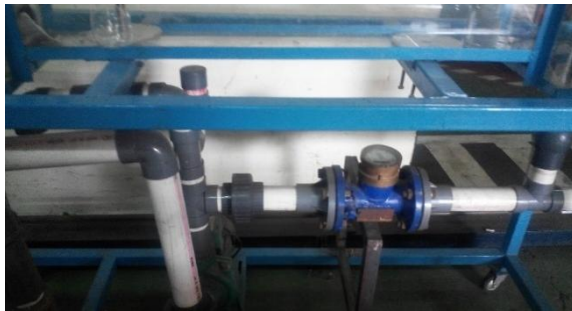
Gambar 4.27 Pemasangan Instrumen alat ukur kapasitas aliran aliran
