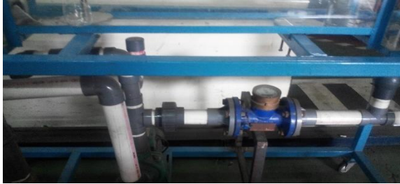
Gambar 4.24 Pemasangan Instrumen alat ukur kapasitas aliran aliran
