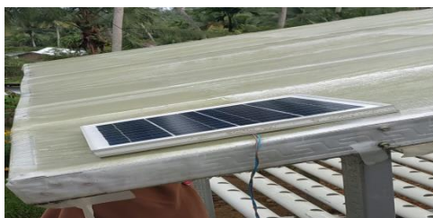
Gambar 6. Pemasangan Panel Surya
