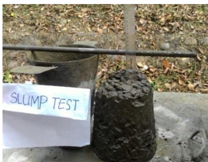
Gambar 3. Pengukuran slump beton
