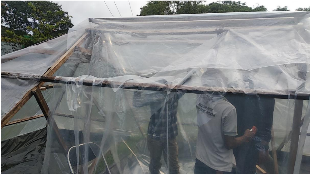
Gambar 10. Modifikasi atap prisma dengan pemasangan pintu angin dibagian atas untuk memperlancar keluarnya uap air.
