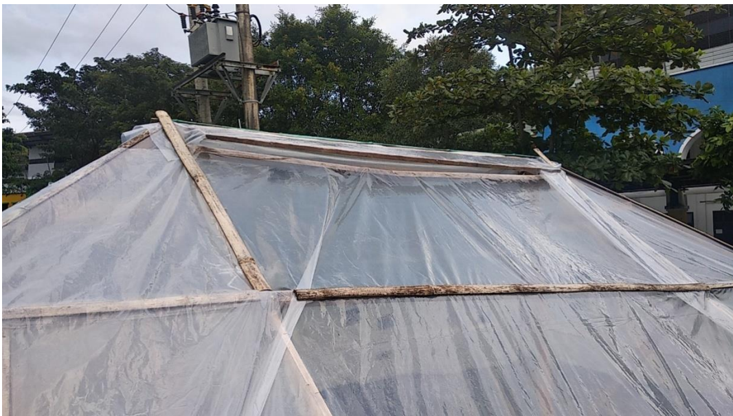
Gambar 11. Mengganti plastik atap prisma yang rusak dengan yang baru.
