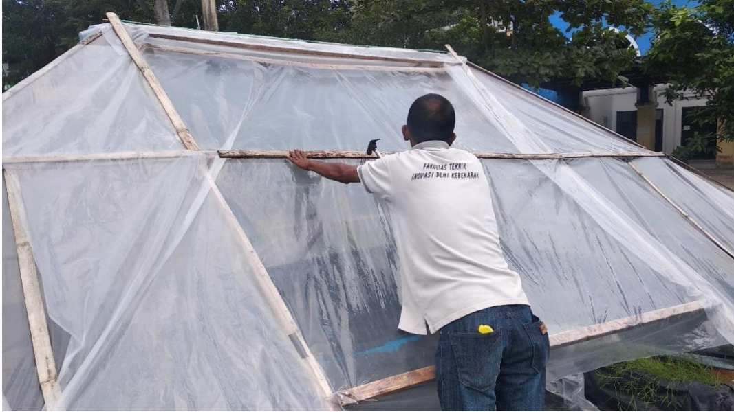
Gambar 12. Pemasangan kayu penahan plastik, agar kuat menahan terpaan angin.
