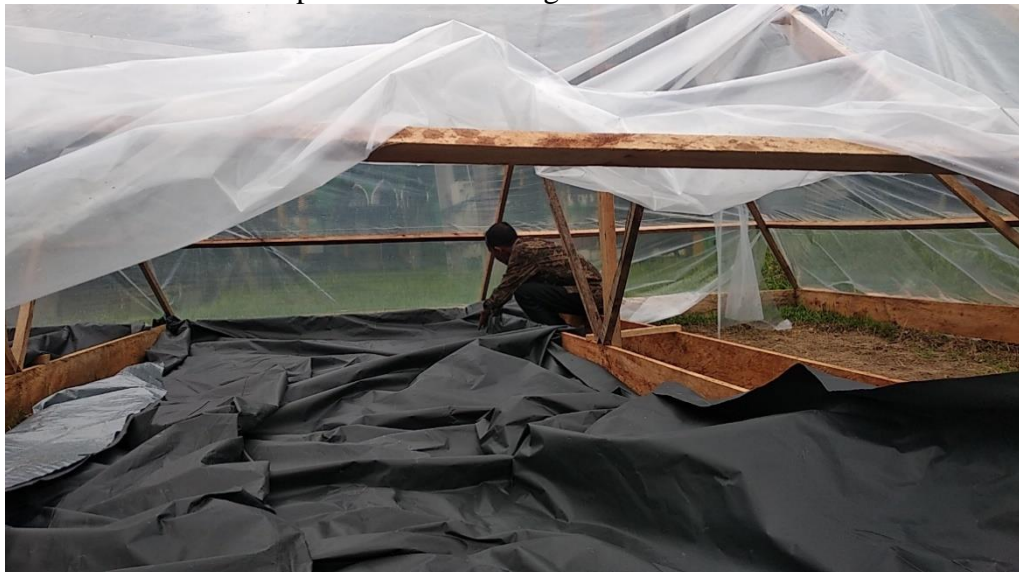
Gambar 2. Pemasangan plastik geomembran sebagai dasar kolam.
