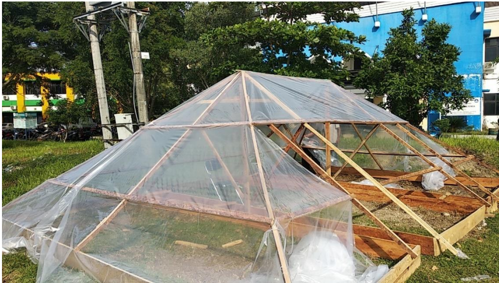
Gambar 3. Pemasangan atap prisma, dari plastik tebal bening.
