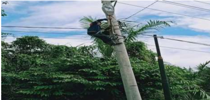
Gambar 1. Perbaikan PJU oleh Teknisi Penerangan Jalan di Aceh Singkil
