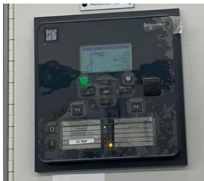
Gambar 2. Rele Proteksi yang Digunakan di PT.PIM
