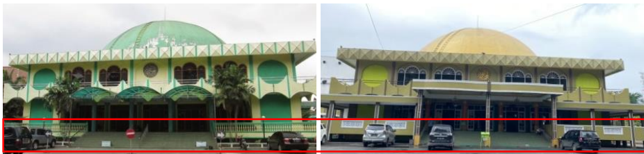
Gambar 4. Penambahan Teras pada Masjid
