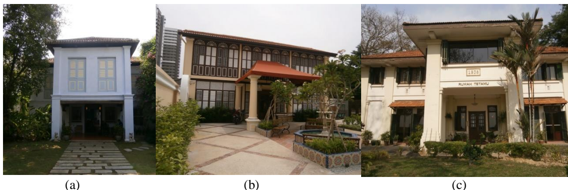
Gambar 2. Tampak fasad depan: (a) 23 Love Lane Hotel; (b) Jawi Peranakan Mansion; dan (c) USM Guesthouse setelah pekerjaan pemugaran
