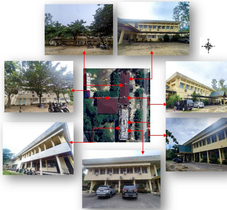
Gambar 7. Kondisi Eksterior Bangunan Eksisting.
