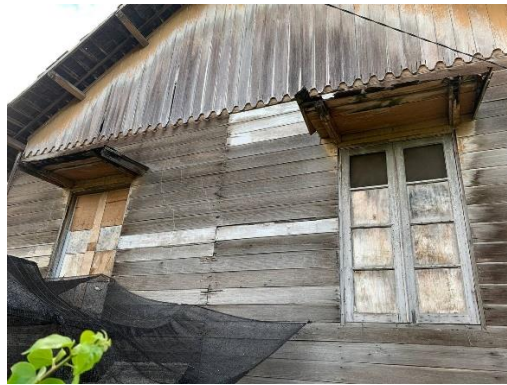
Gambar 10. Foto Dokumentasi Tampak Kiri Bangunan
