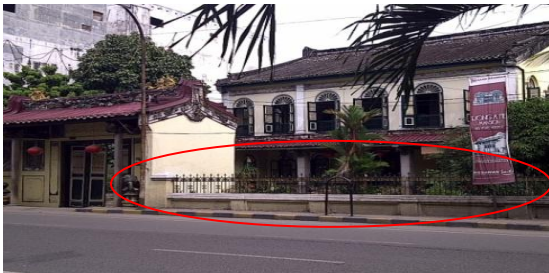
Gambar 12. Elemen Dinding Pembatas Transparan pada Rumah Tjong A Fie Sumber: Data Lapangan, 2013
