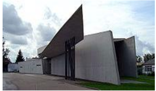
Gambar 30. Stasiun pemadam kebakaran Vitra (1994), Weil am Rhein, Jerman
